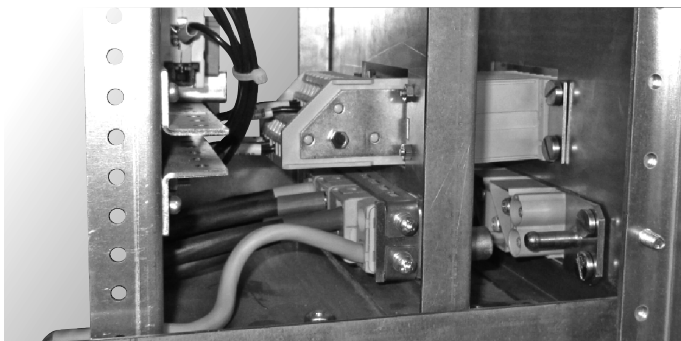
◀ Пример установки соединителя СПН1
